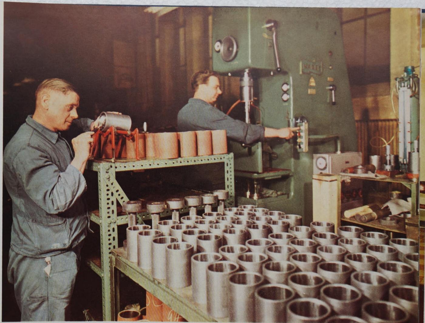
Prüfung auf Porenfreiheit und Hohnen der hartverchromten Lauffläche der Schleudergußzylinder für Kolbenzähler
