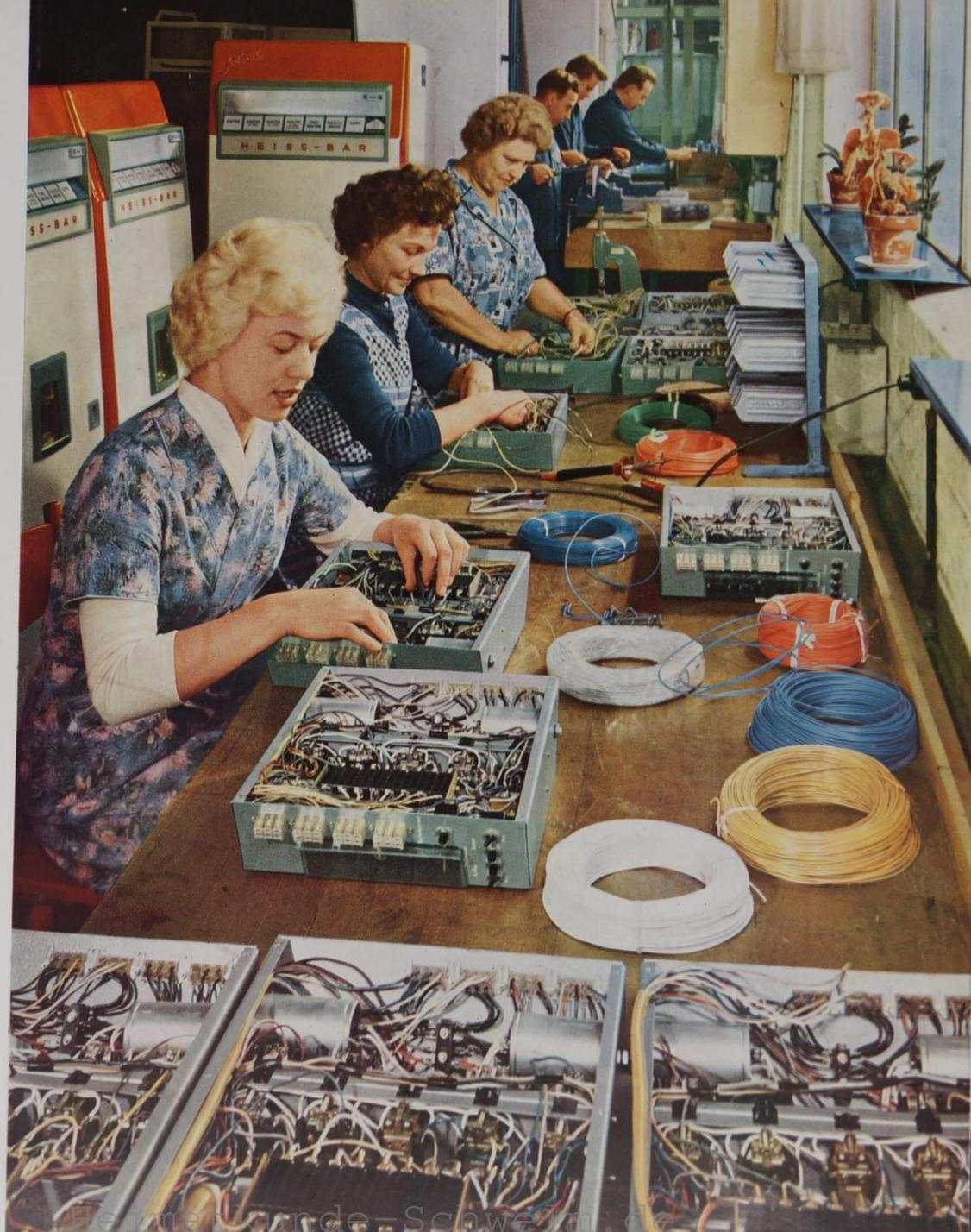
Ein Bild aus der Vormontage zeigt die Montage und Verdrahtung der Schaltrelais,
