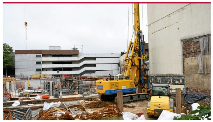
Mit bis zu neun Meter tiefen mit Beton verfüllten Bohrlöchern wird der Grund unter dem Haus Neumarkt 3 stabilisiert.
