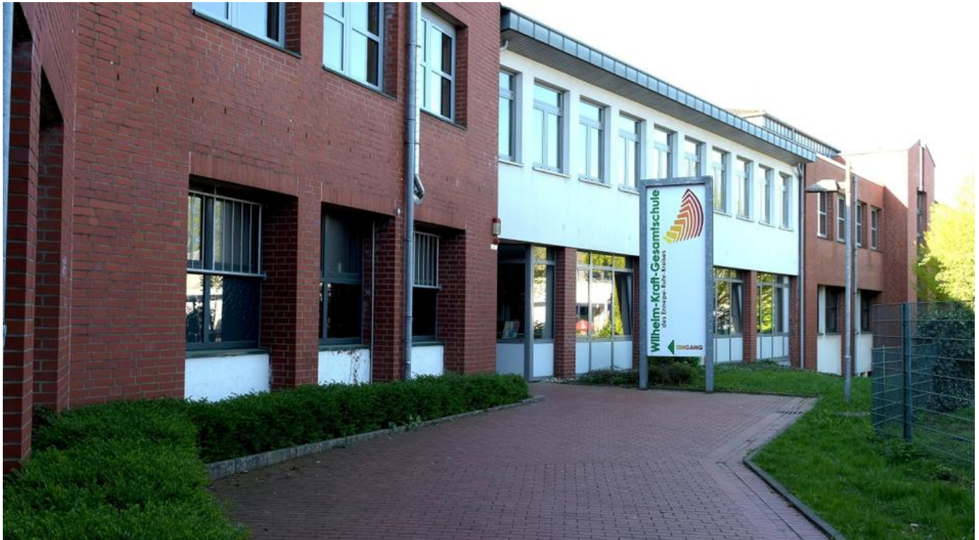
Die Kosten für die geplante Sanierung der Wilhelm-Kraft-Gesamtschule sind von elf auf mehr als 34 Millionen Euro angestiegen. Foto: Bartsch,G. (b13)/Bartsch, Gerhard (b13)
