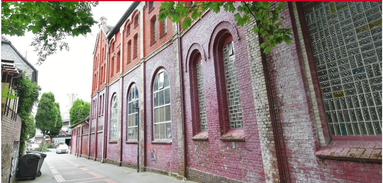
Schwelm - Kesselhaus und Patrizierhaus der Brauerei Schwelm Foto: Bernd Richter Foto: Bernd Richter
